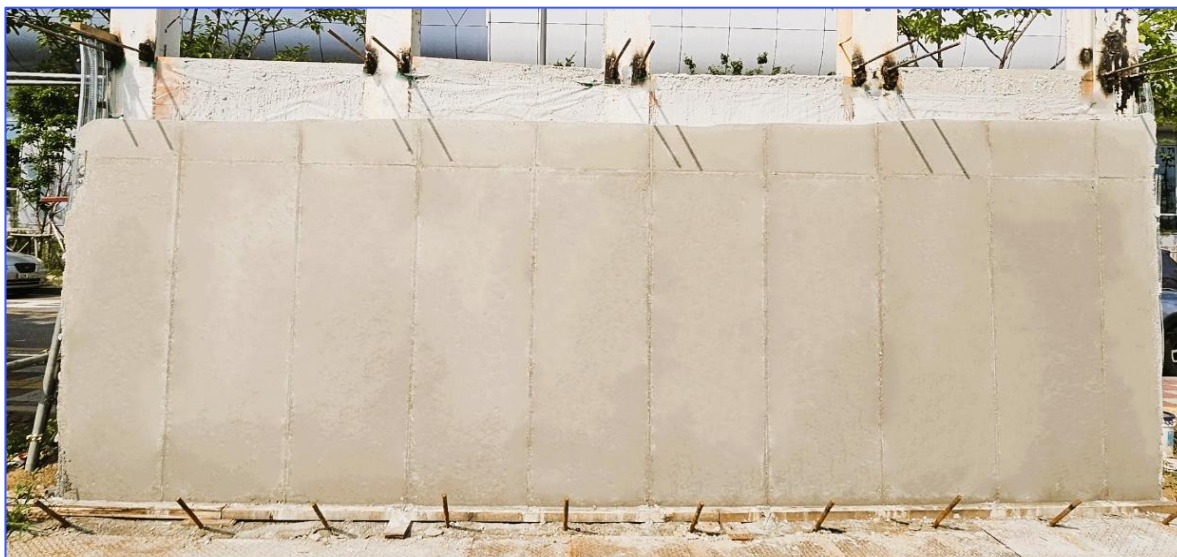
타설 후 타설면 상태
