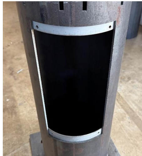
하부 점검구(포충기 설치)
